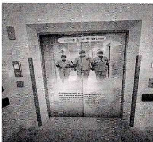
Imagen No.24 Ascensores nuevos instalados y en funcionamiento
